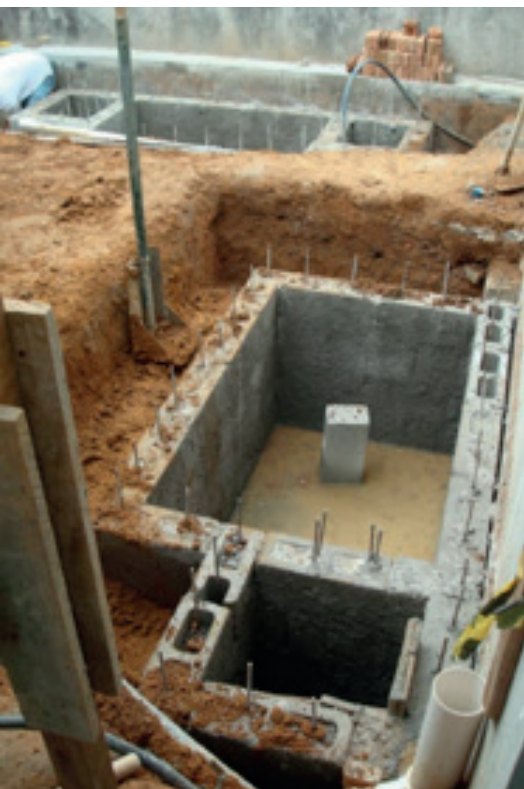
Tanques de tratamento em construção (à esq.) e tanque de “wetlands” construídos para tratamento de água cinza recém plantada e em operação (à dir.)
