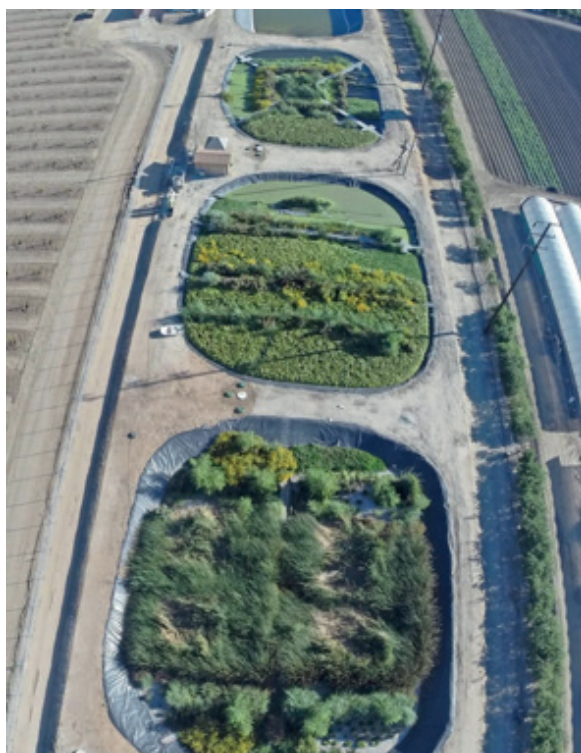
Vista aérea do sistema de tratamento
