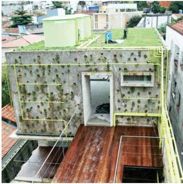
Figura 3 – Telhado verde sobre laje de concreto proporciona conforto termo-acústico
