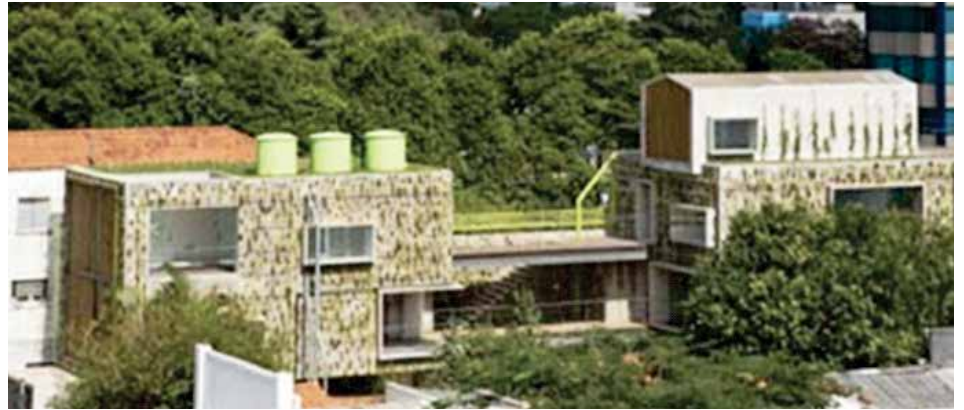
Figura 13 – Edifício Harmonia 57: vista lateral do prédio na subida da Rua Harmonia
