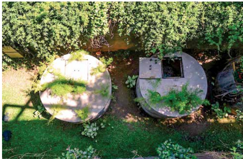
Figura 9 – Cisternas recebem excedente de água do telhado verde (G)
